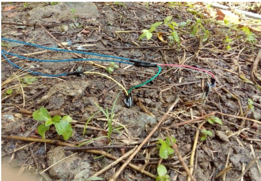
Hình 8. Lắp đặt các cảm biến độ ẩm.
