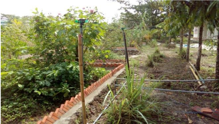
Hình 7. Lắp đặt đường ống và các béc phun.
